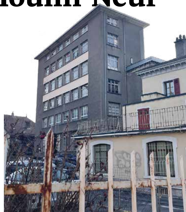
L'ancienne usine du Moulin-Neuf (le bâtiment gris) est située en zone réservée qui court jusqu'en janvier 2027. Son propriétaire a l'intention de la démolir pour y construire des logements. | K. Di Matteo
