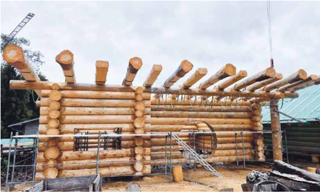
Compas, tronçonneuses et couteaux à deux mains sont les outils utilisés pour la taille de la fuste, technique venue des pays scandinaves et d'Europe de l'Est. | Ville de Montreux
