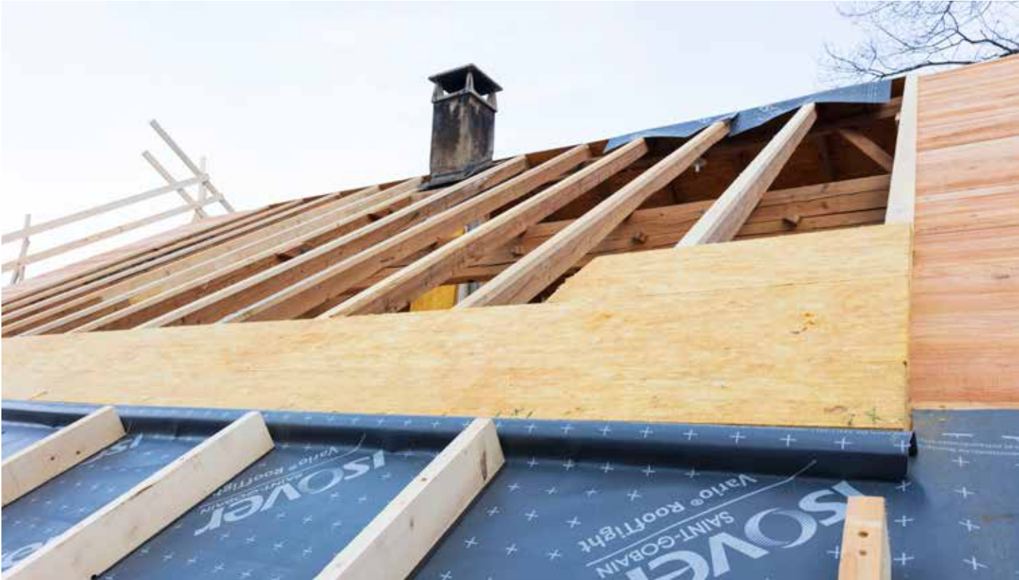
Sous forme de grands panneaux, l'isolant Isorigid de l'entreprise Isover Saint-Gobain permet d'isoler le toit par l'extérieur, sans toucher à la charpente existante. Un moyen d'éviter les nuisances liées aux travaux intérieurs, surtout si les pièces sont occupées. | Isover
