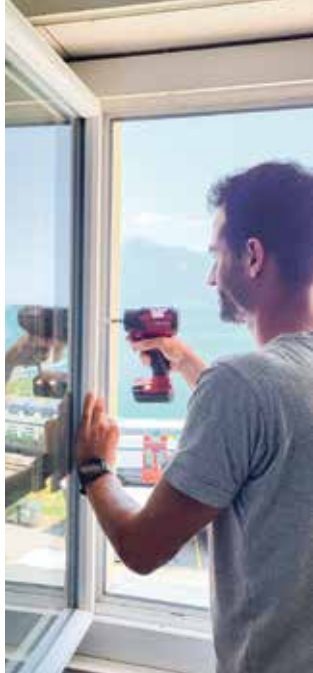
Un menuisier spécialisé de l'ébénisterie et menuiserie Baer SA installe des petites réglettes d'aération: une solution simple, rapide et peu onéreuse pour corriger les problèmes de condensation. | Baer SA
