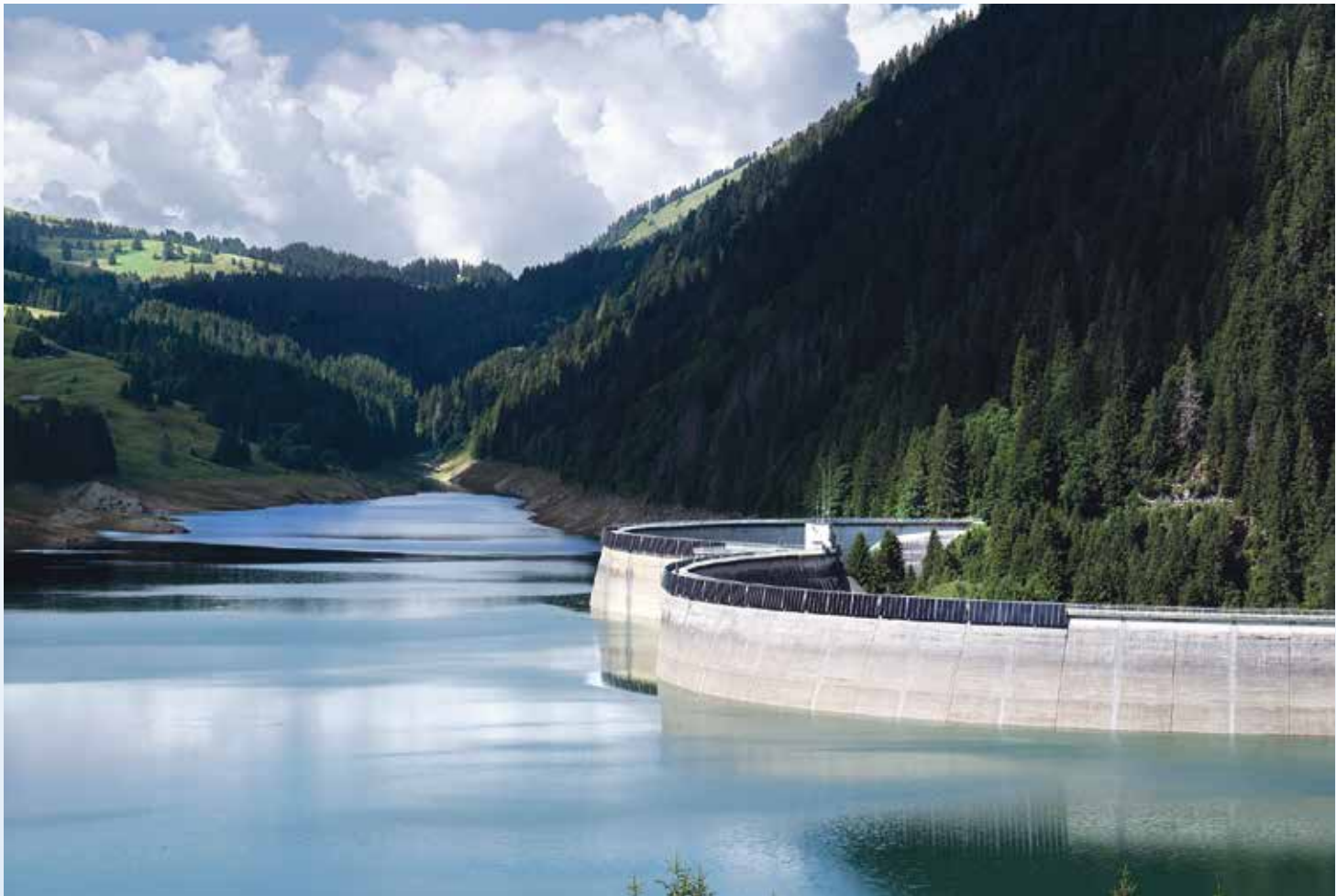
Le barrage de 1970 offre son profil de «cœur» dans un écrin somptueux. Ses deux pans sont dits en double-voûte, car arqués dans le sens horizontal et vertical. En accédant à l’ouvrage par une route de 6 km, on peut se balader au sommet de ses murs qui retiennent 52 millions de m 3 d’eau à 1’255 mètres d’altitude. Le barrage l’Hongrin est exploité par les Forces motrices Hongrin-Léman.
