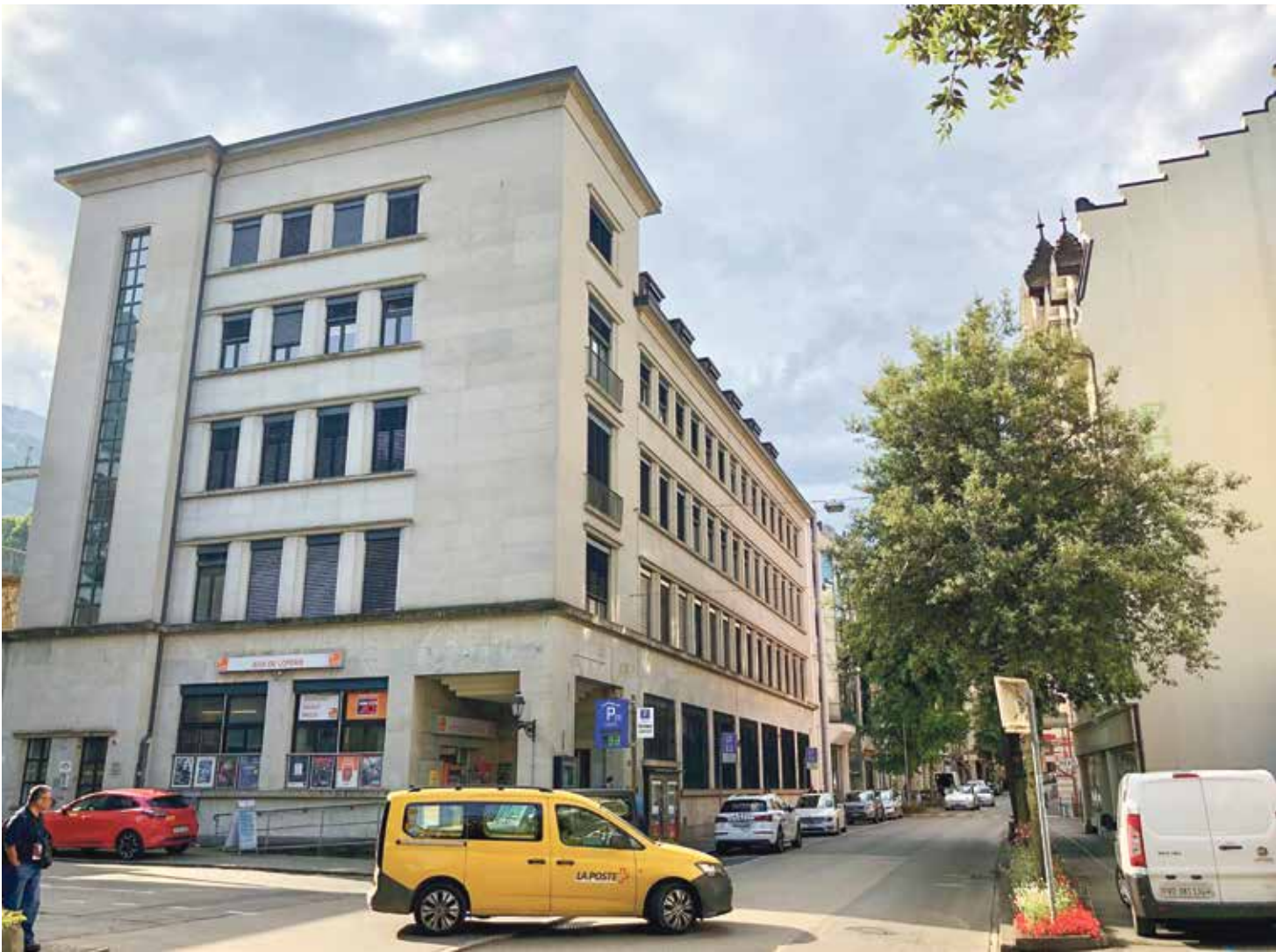
Situé à quelques pas de la gare, le guichet postal de Montreux 1 occupait le rez de cet immeuble. Il a cessé son activité en 2023. | R. Brousoz
