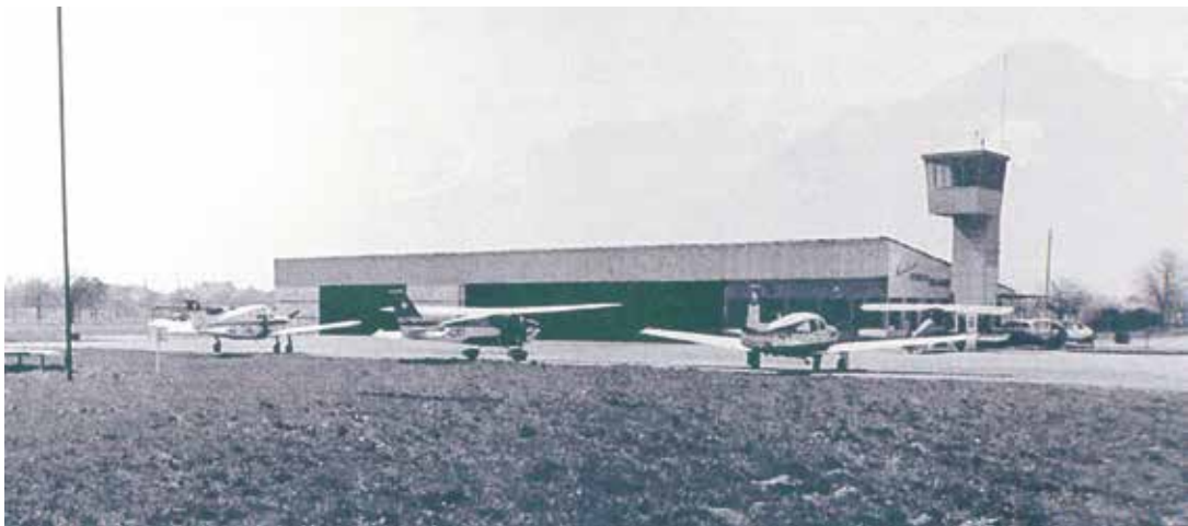
L'aérodrome de Montreux à Rennaz, vers 1965.
