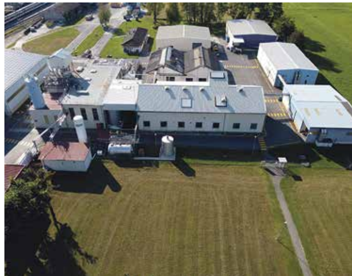
La nouvelle unité de production de Prayon prendra place sur ce terrain situé en zone industrielle à l'entrée du village de Bex.
