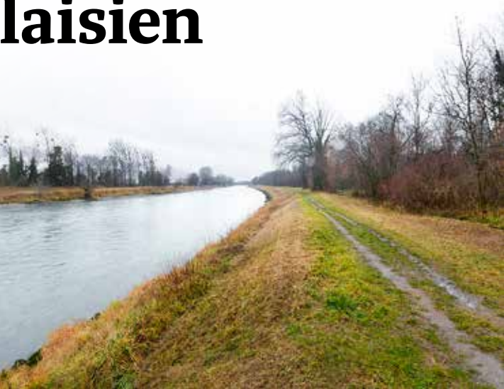
Aux Iles des Clous (entre Yvorne et Vouvry), les digues seront modifiées et le cours du Rhône élargi. | C. Dervy - 24 heures
