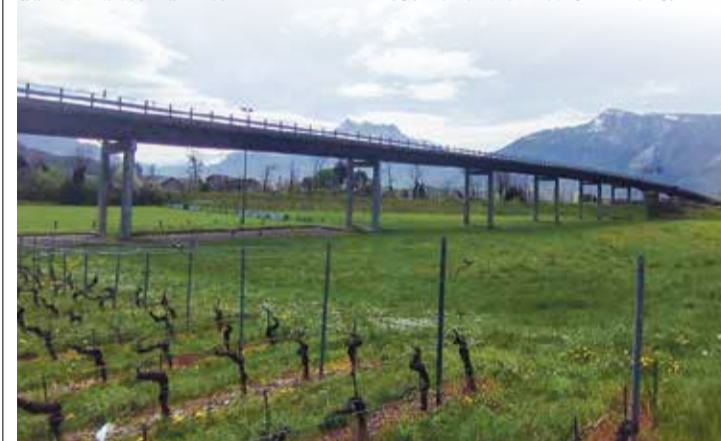
L'ouvrage d'art a une longueur de 545 m.
