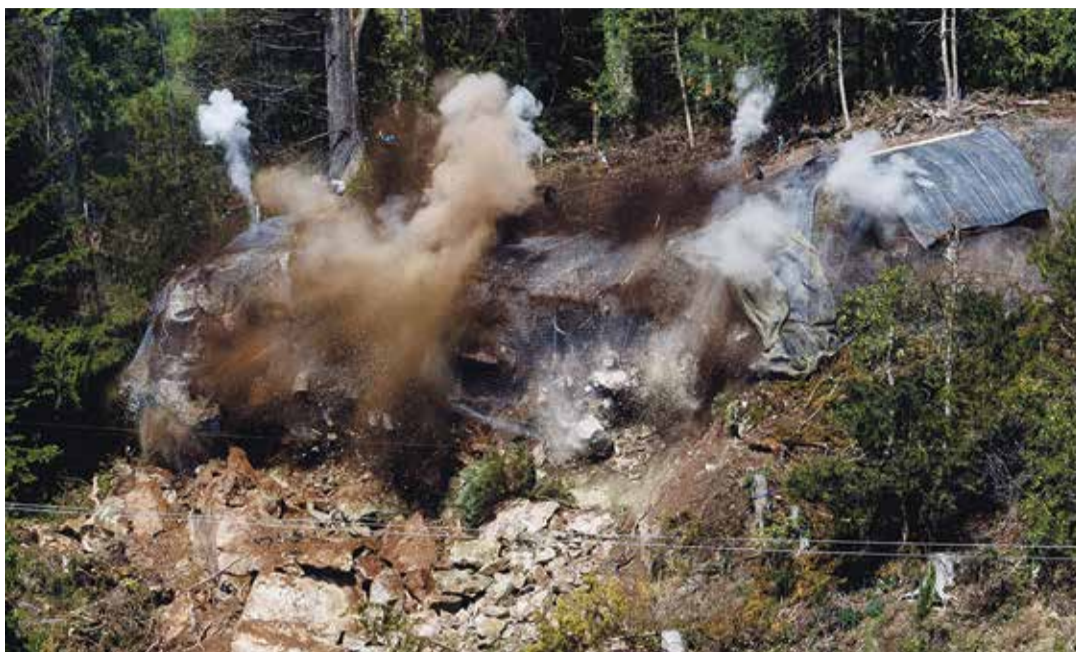
La déflagration et la vibration de l'explosion ont bien pu être ressenties par le public, qui était posté à 400 mètres de la paroi minée. Cette dernière ne devrait plus présenter de danger. | C. Dervev - 24 heures
