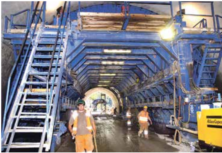
Les derniers grands travaux dans le tunnel, il y a 20 ans.
