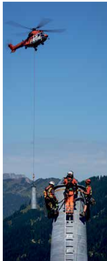
La pose des pylônes, en août dernier, aura été l'un des moments forts du chantier. | Portes du Soleil SA
