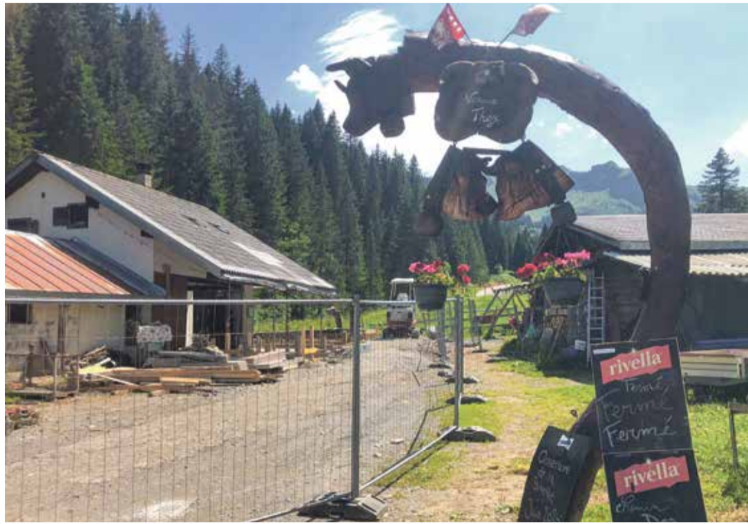
Fermée actuellement pour la saison en raison de travaux, la cantine de They va se voir passablement modifiée. Ces derniers doivent permettre d'augmenter sa capacité d'accueil. | P. Genet
