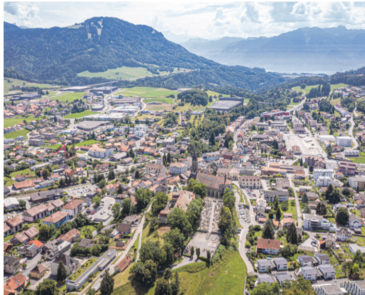
Le chef-lieu du district est en pleine mutation: déplacement de sa gare, construction de nouveaux quartiers et nouvelle école primaire sont au programme. | DR
