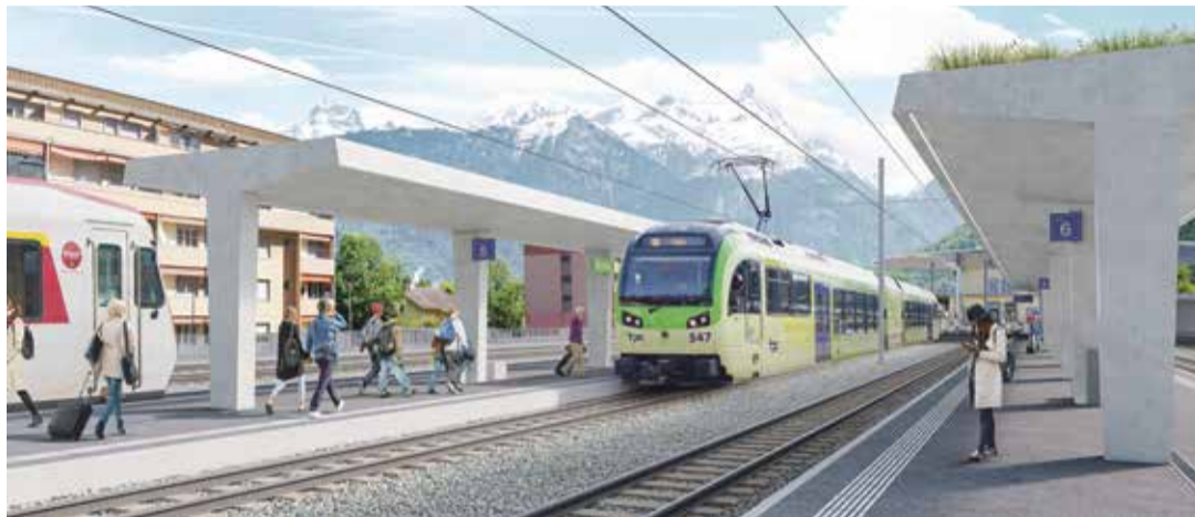
La gare unique de Monthey, avec un nouveau bâtiment, deviendra un véritable pôle régional de transports publics.
