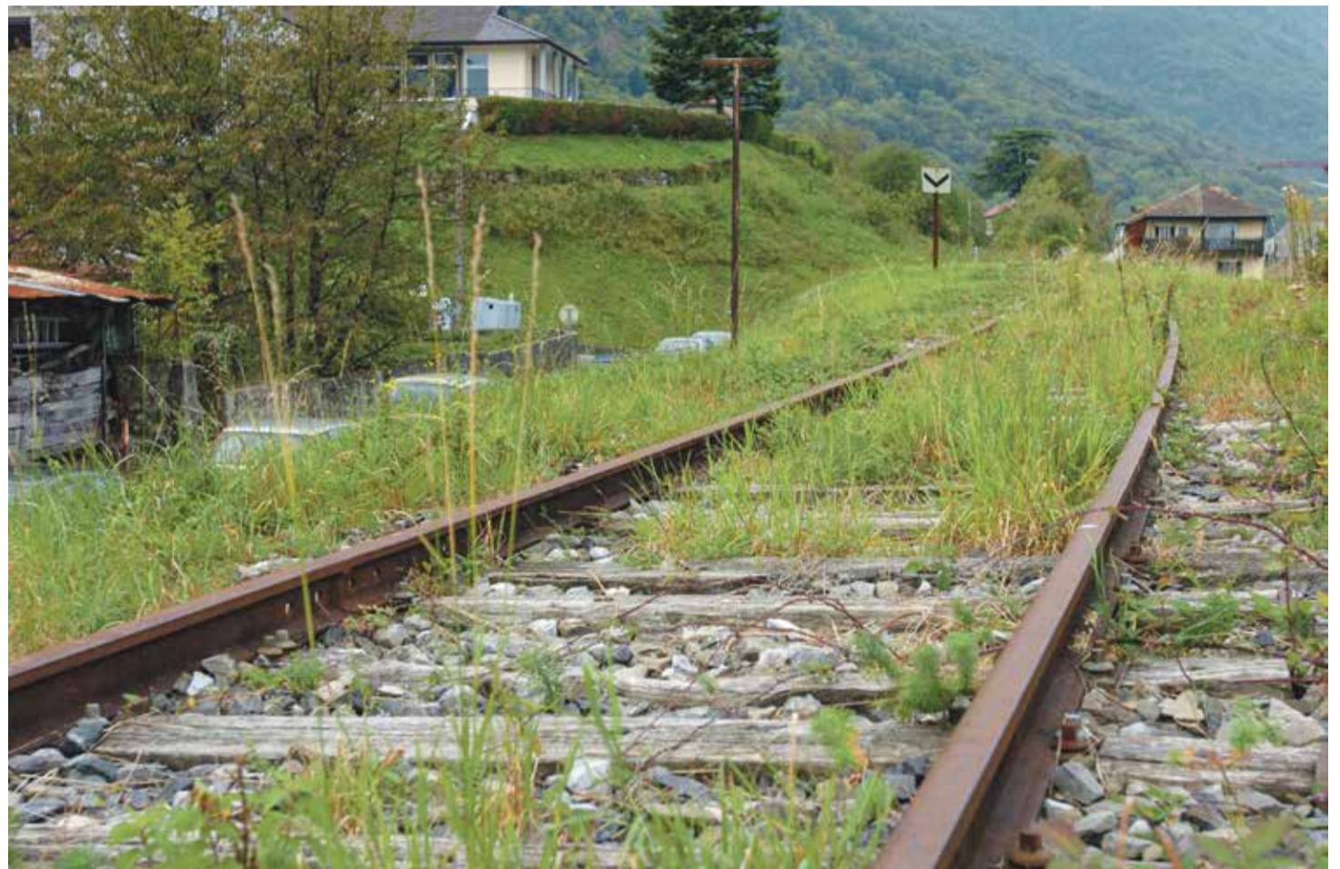
La ligne entre Saint-Gingolph et Evian (17,8 km) est totalement désaffectée depuis 1998.
