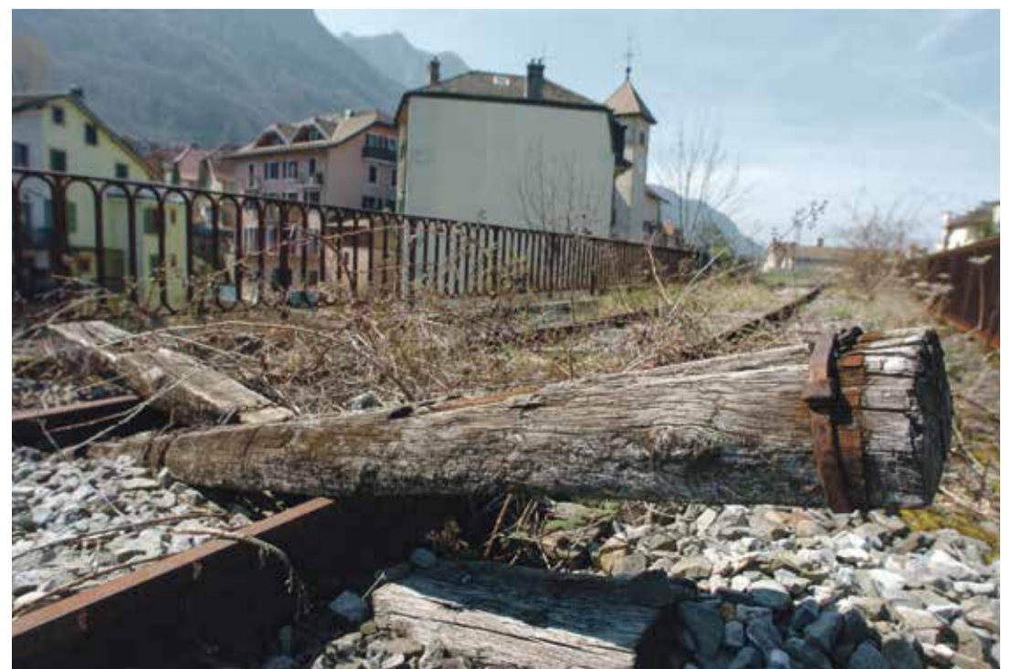
Selon les estimations actuelles, les premiers travaux pourraient intervenir en 2026.
