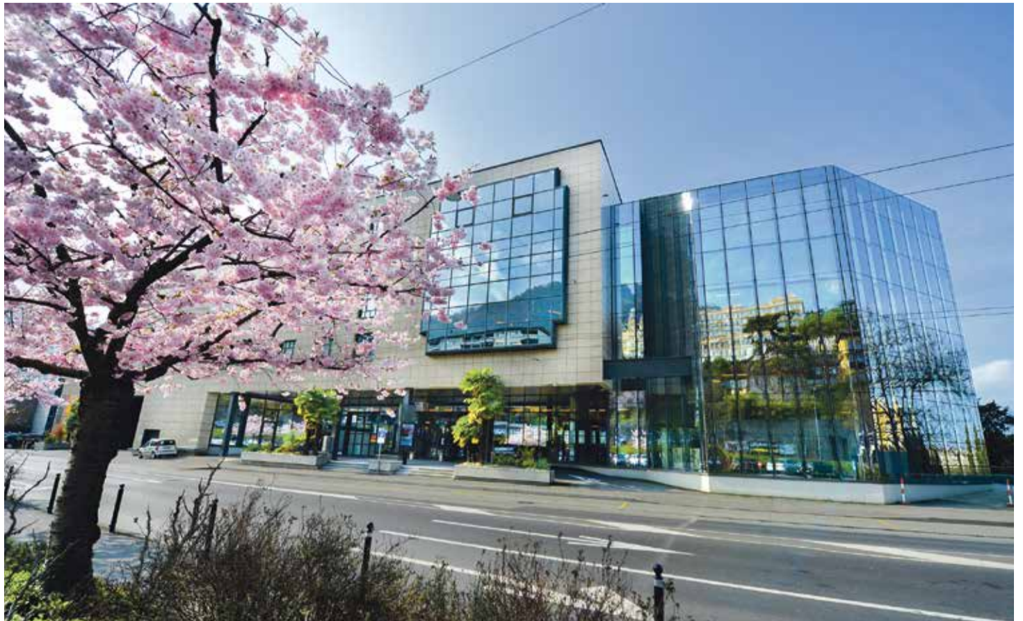
Les travaux doivent commencer l'an prochain. Ils sont estimés à 78 millions, dont 21 à la charge de la Commune.
