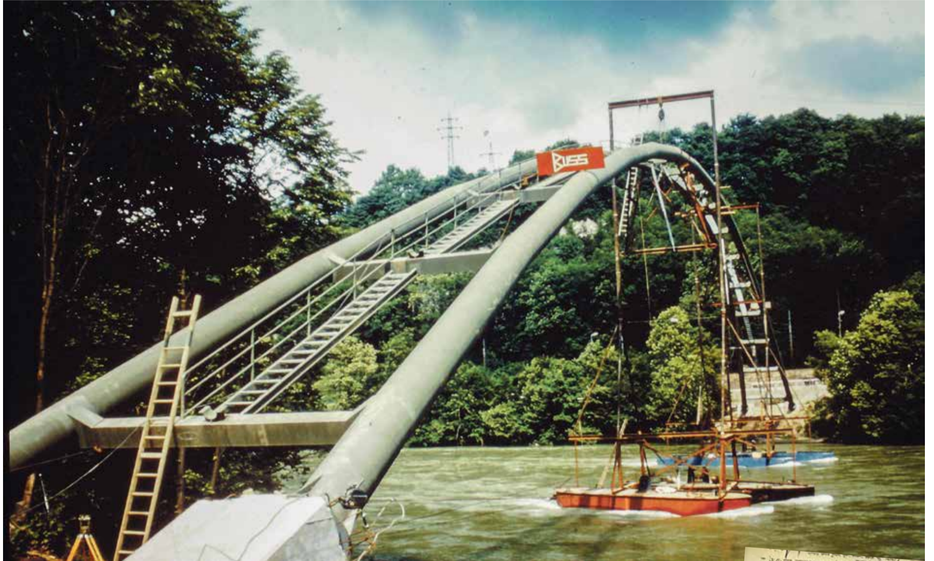
La passerelle posée en 1965 sur le Rhône a permis d'alimenter la rive gauche du fleuve en plusieurs endroits.
