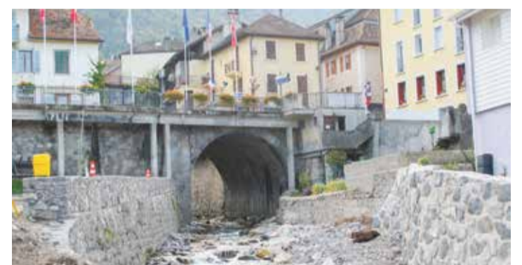
Berges renforcées entre pont de la Douane et embouchure. | C. Boillat
