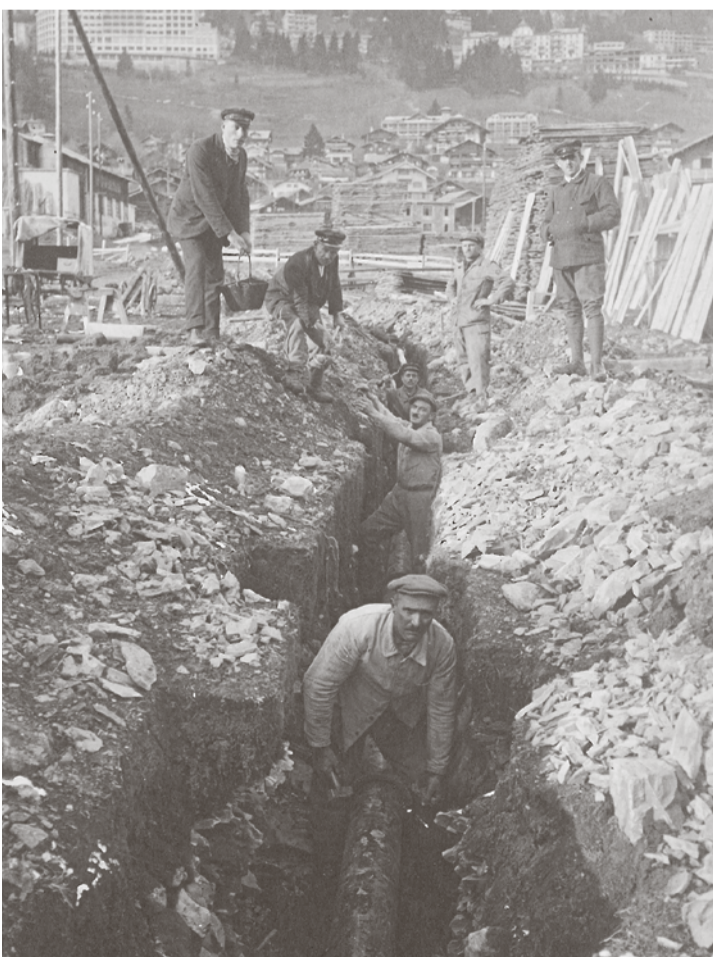
Été 1922, des ouvriers creusent pour installer des conduites à Leysin.
