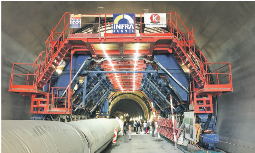
Les visiteurs ont pu s'enfoncer dans le futur tunnel de contournement des Evouettes par le portail nord. L'ouvrage de 657 mètres a été percé aux trois quarts. Il sera terminé au plus tôt fin 2024.
