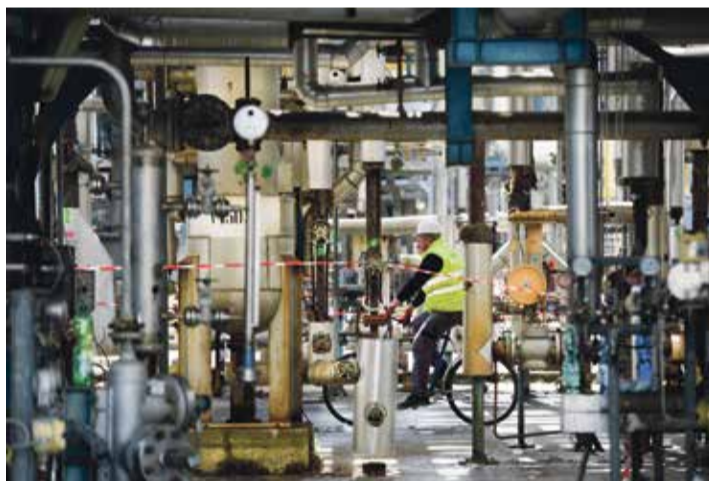
Les travaux se poursuivront encore trois à quatre ans.
