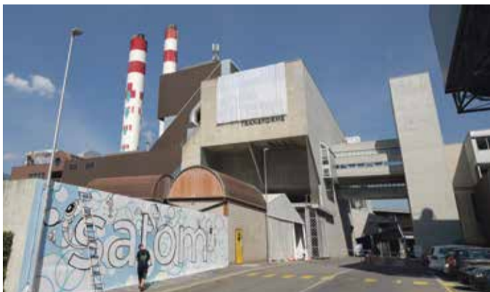
Les deux cheminées hautes de 86 mètres seront remplacées par une seule, plus basse, mesurant 45 mètres. | C. Dervev - 24 Heures
