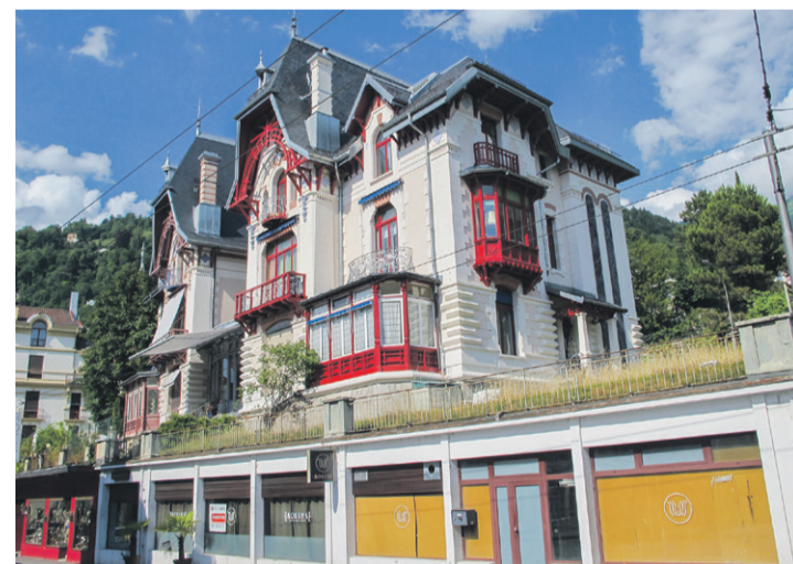
Villas bien connues des Montreusiens, « Germaine » (à g.) et « Châtelaine » ont été édifiées en 1899.
