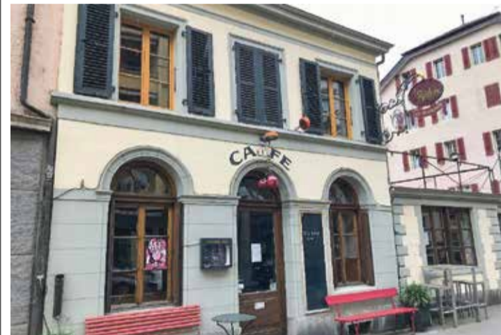
Le petit sinistre a entraîné de gros dégâts à l'intérieur du restaurant.
