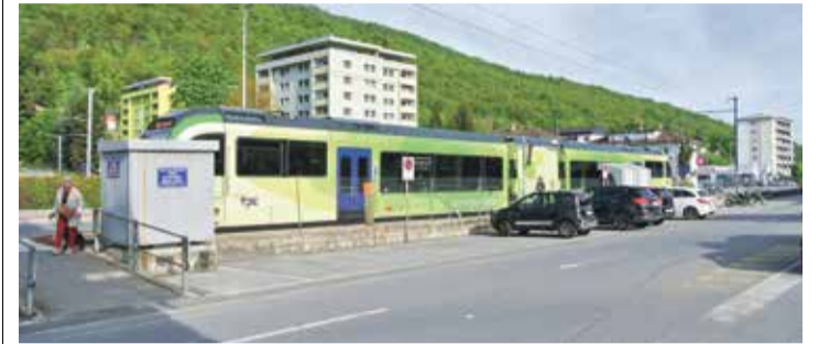
Elargir cette halte aurait un impact sur le parking du centre commercial.
