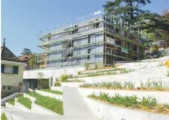
Initié il y a 10 ans, le projet de bâtiment multigénérationnel est sorti de terre. | X. Crépon
