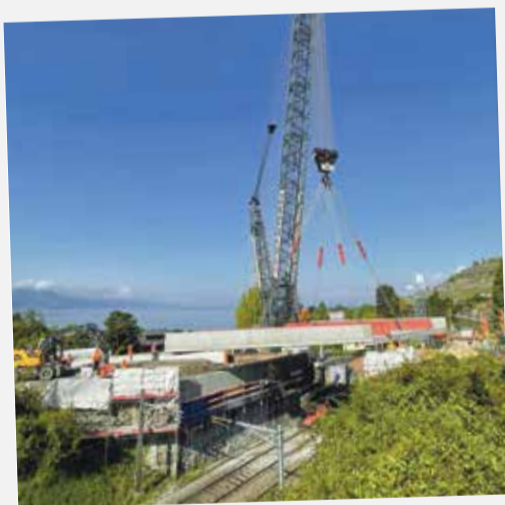
Pose d'un nouveau pont CFF à Corseaux ce matin 9h.
