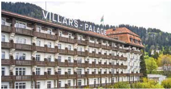
La façade a été entièrement réhabilitée.
