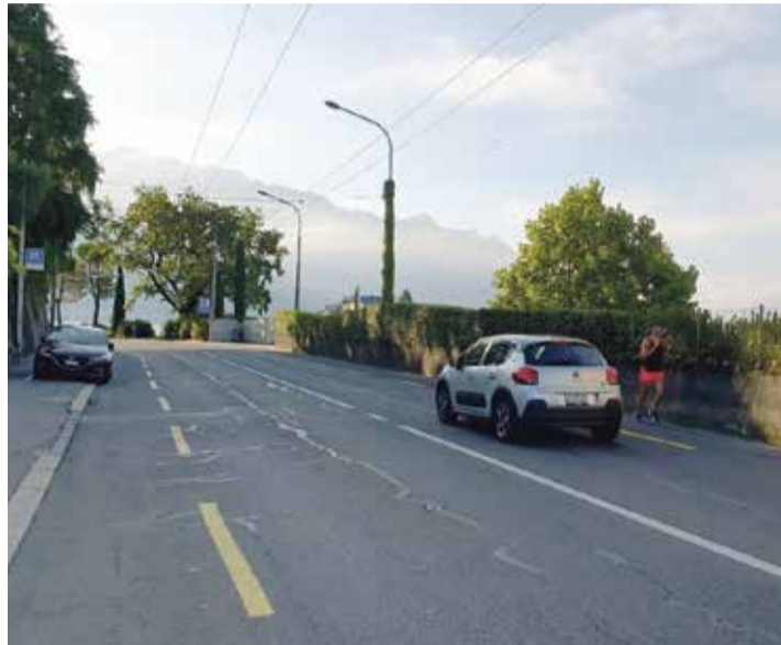
À la rue du Lac, le risque existe en aval avec des piétons qui utilisent parfois la bande cyclable, en l'absence de trottoir continu. | Ville de Montreux
