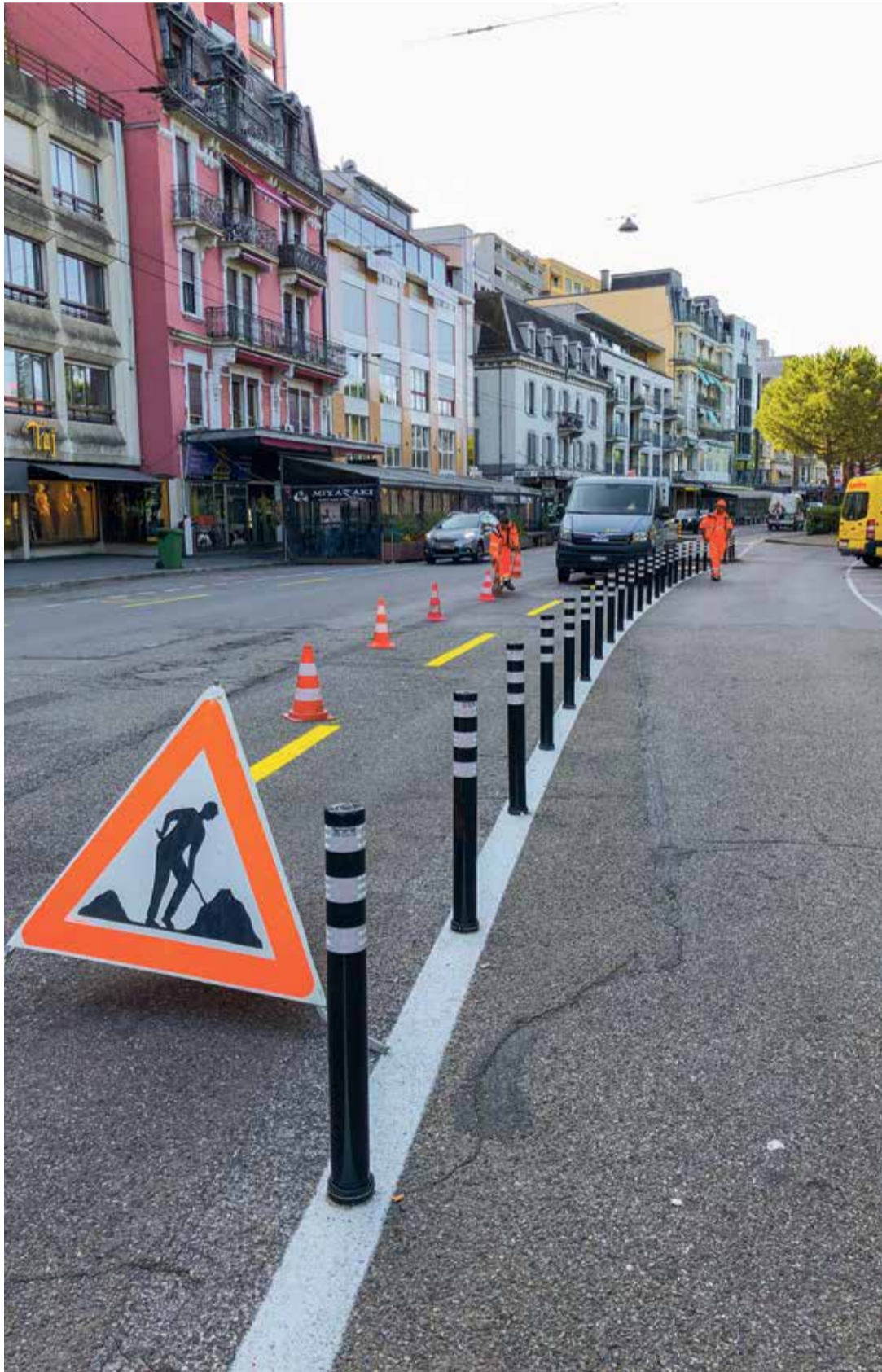
Plusieurs travaux de réfection du revêtement et d'aménagement de la Grand-Rue ont été effectués en avril à Montreux. | X. Crépon
