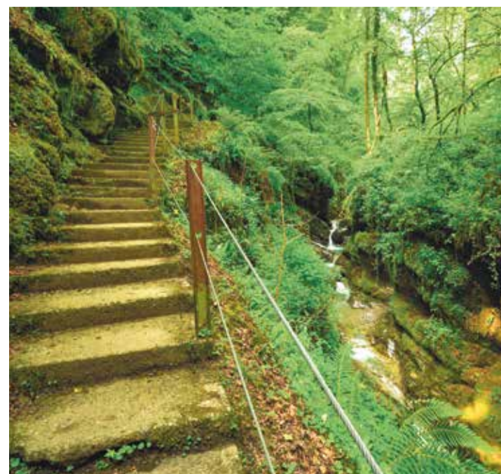
Des filets pare-pierres seront posés contre la falaise sur une longueur de 85 mètres. | G. Lombardi
