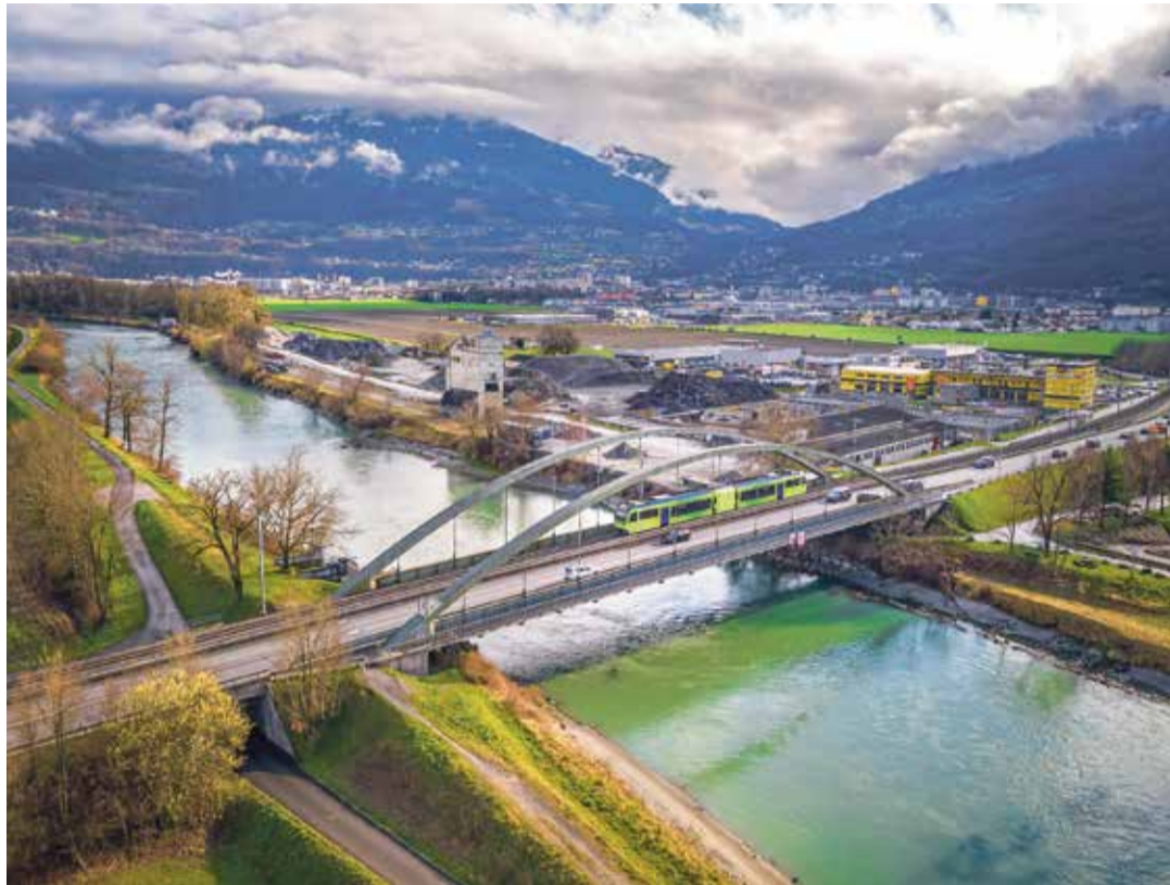
La place libérée par la disparition des voies de l'AOMC sur le pont de Saint-Triphon permettra d'y créer une troisième voie pour les voitures. | DR/Studio54 - O. Maire
