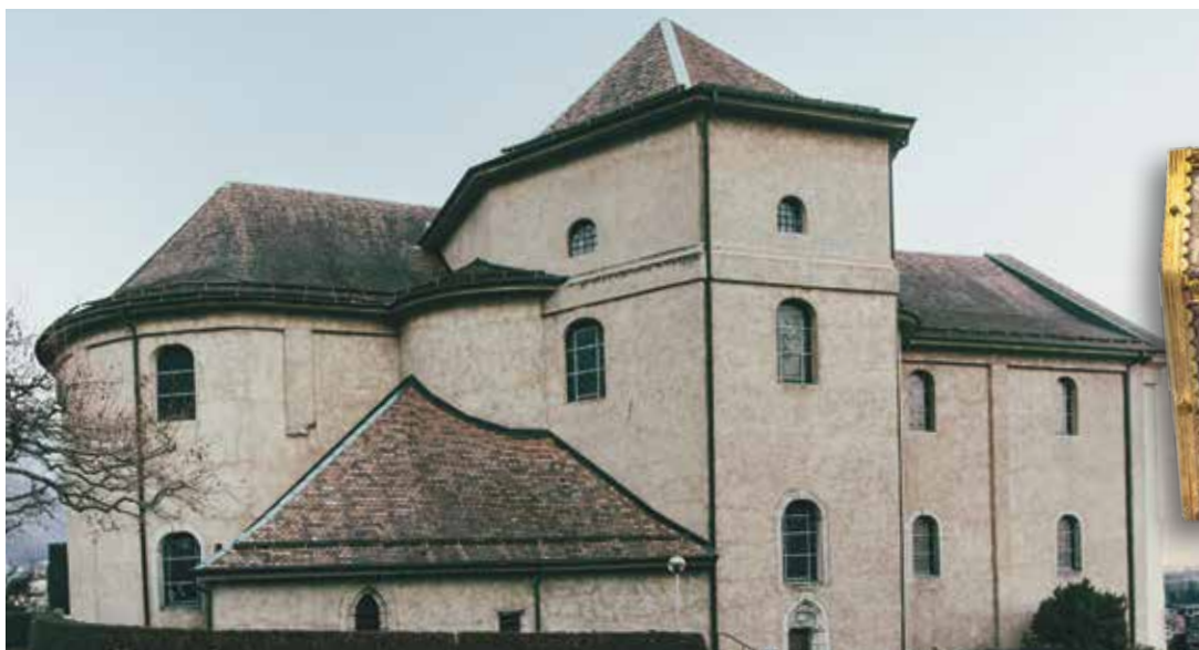
Alors jugé vétuste, l'édifice a été reconstruit et agrandi en 1822. Subsiste de l'ancien lieu de culte le clocher gothique.
