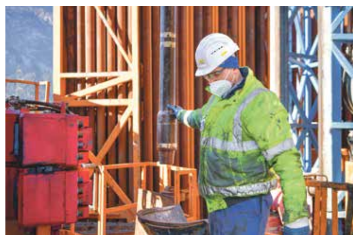
Des tiges de 15 m chacune sont assemblées sur la tour et emmenées par la foreuse dans le sous-sol. | C. Dervev - 24 heures
