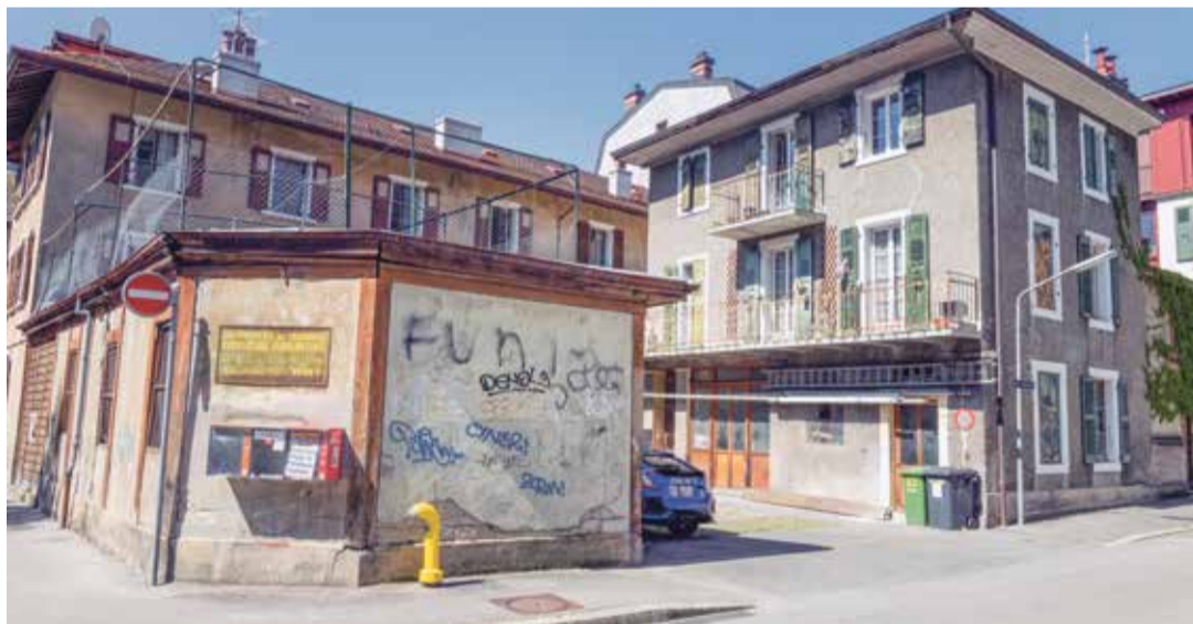
Aucun permis n'a encore été demandé, mais à terme tout l'ilot sera transformé. | O. Vogelsang - 24 heures archives
