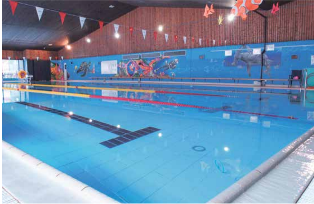
La structure des piscines et leur machinerie doivent être remises aux normes.
