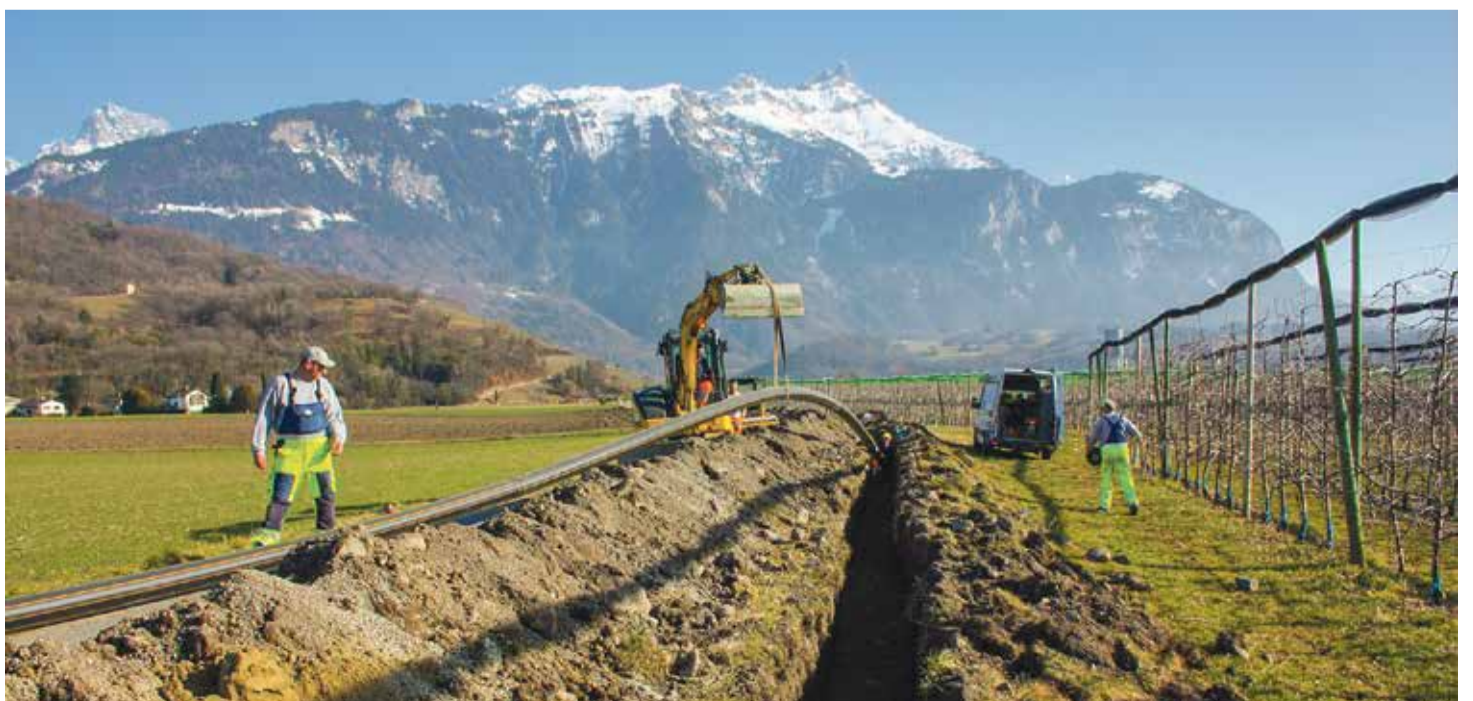
Certificats CO 2 , biogaz, captage et valorisation des émissions de CO 2 . Le gaz ambitionne d'être tout vert demain. Ici : travaux de remplacement d'une conduite de gaz à Bex. | © Holdigaz
