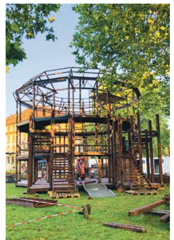
Le bâtiment en bois est inspiré des théâtres élisabéthains.
